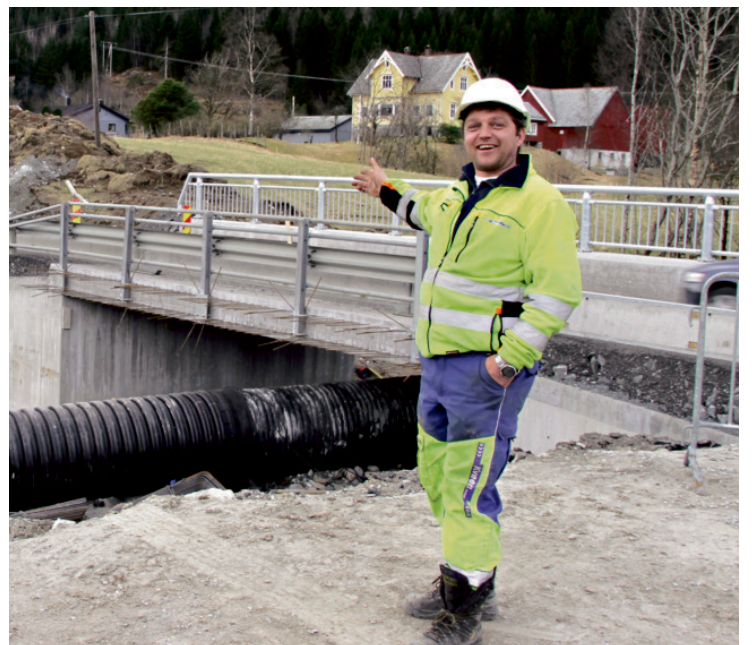
– Her har det allereie kome bru i midtre, skjemat bas Vidar Edelston og viser til arbeidet som Kåre Bø held på med for å støype ny Bakke bru. Tilhøyrande gangvegbrua er allereie på plass.
